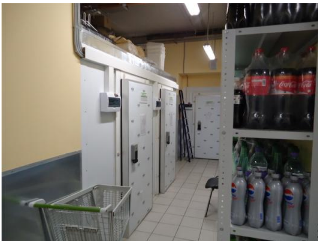
Фото 6. Цокольный этаж. Складские помещения
